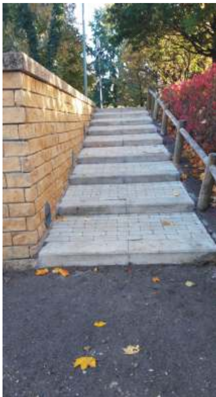
Accès terrain multisport côté mairie : remise en état complet de l'ensemble des marches qui n'étaient plus en état de sécurité.
