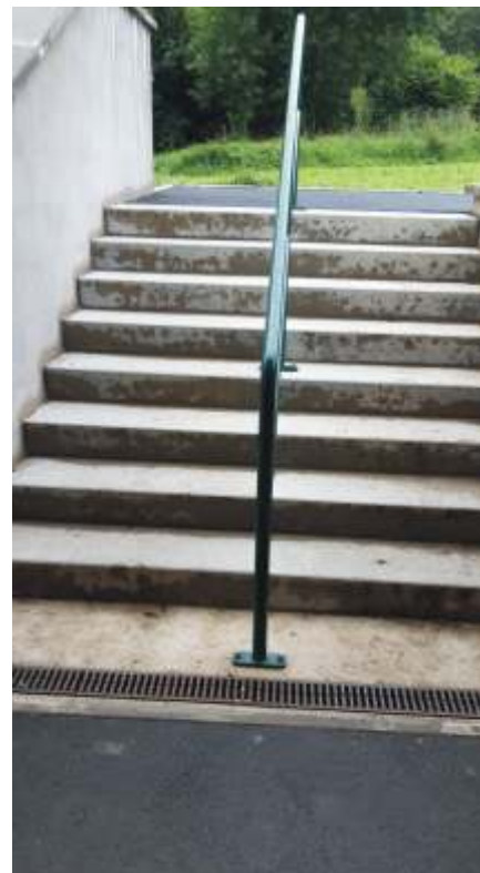
Rampe de l'escalier d'entrée de la maternelle
